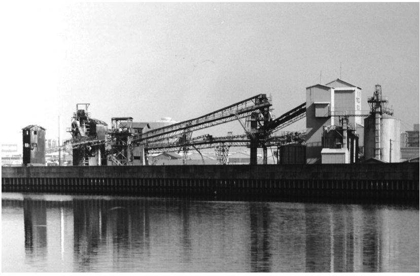
関西初の生コン工場として1953年に操業を開始した大阪セメント工場(大阪市西淀川区)
