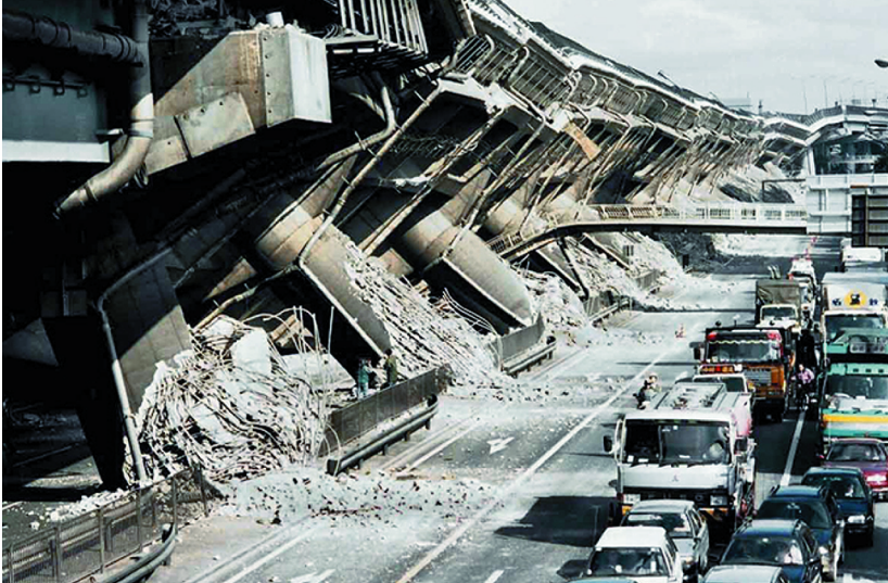
以前から品質不良を指摘されていた阪神高速道路は阪神大震災で倒壊(1995年)
